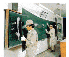
新しい黒板を貼り押え縁を取りつける
