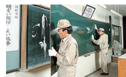
新しい黒板を貼り、押え縁を取りつける
